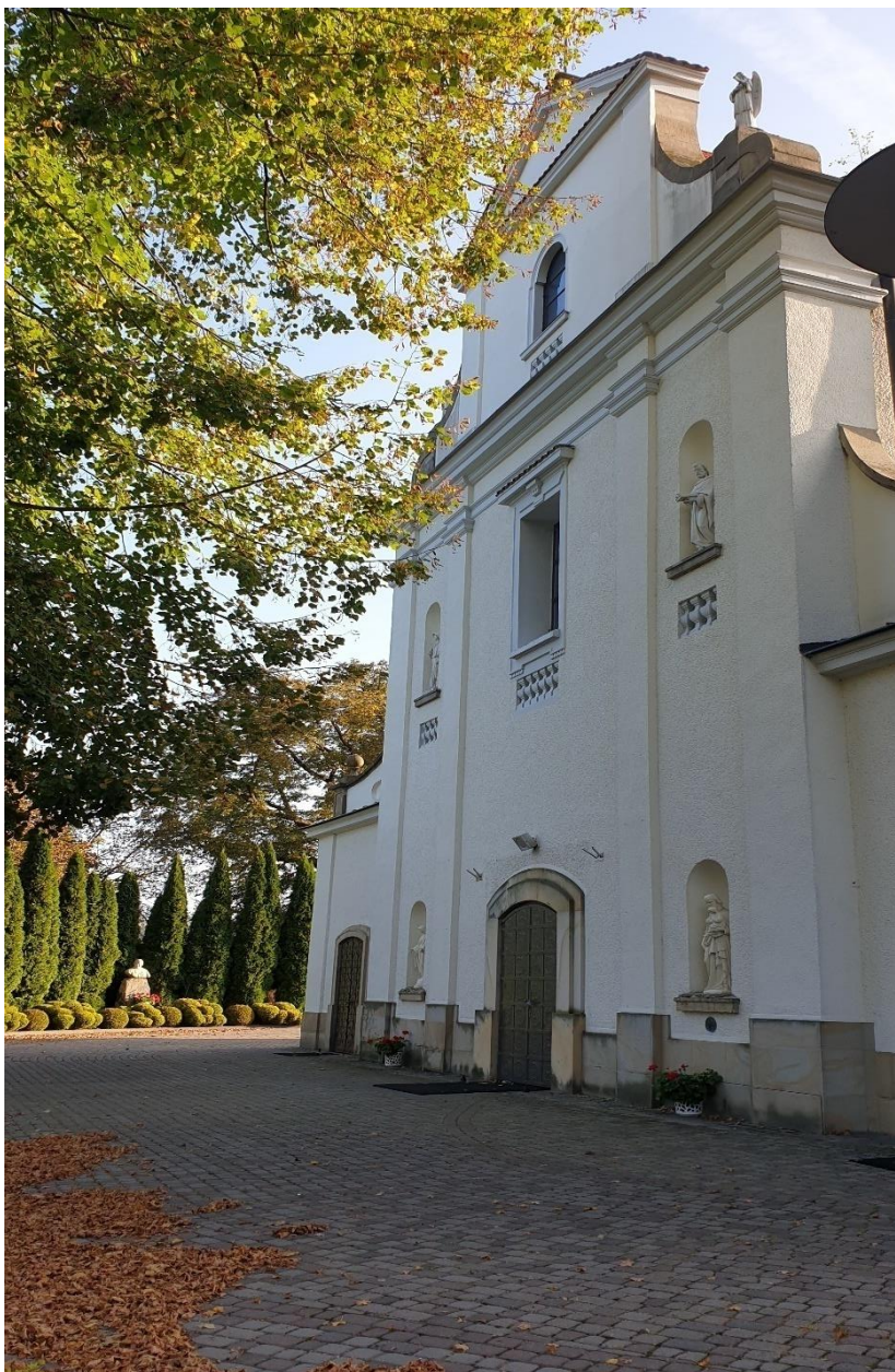
Zdjęcie 3 Kościół parafialny p.w. Narodzenia NMP w Hyżnem
