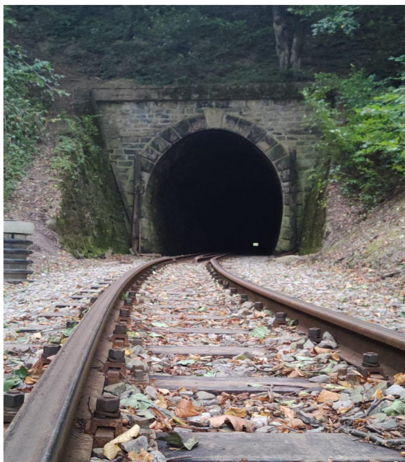
Tunel kolejki wąskotorowej
