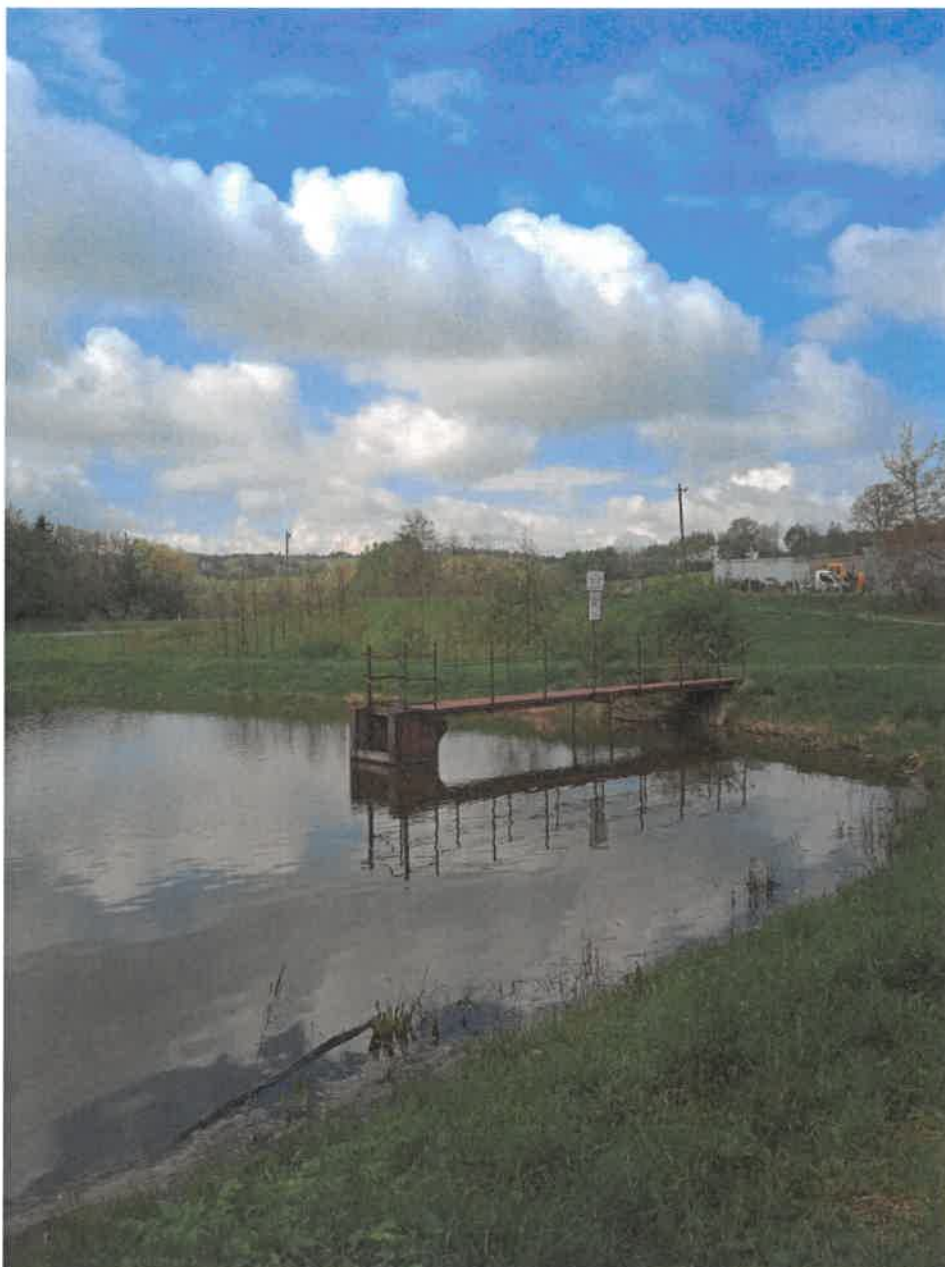
4. Zalew w Dylągówce – zasuwa spustowa na zbiorniku retencyjnym.
